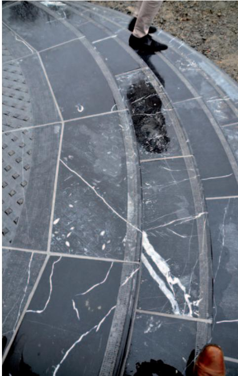
Au total, cet escalier massif semi circulaire de 8 m de Ø en pierre bleue de Wallers inclut 60 marches de 81 cm de long et 15 cm d'épaisseur. Des dalles podotactiles et des bandes antidérapantes ont été façonnées dans l'atelier de Guy Harbonnier. Celui-ci a joué avec les veinages et les calcites de la pierre en glissant harmonieusement des petits motifs sur certaines marches.
