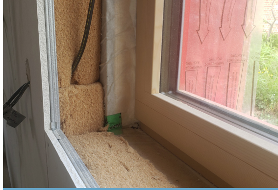
➤ Travaux d'amélioration énergétique du logement
